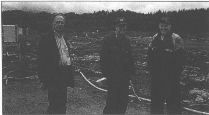
Schaktningsarbetet har börjat för det nya kostallet som kommer att byggas på delar av det nedbrunna stallet. –Det ska bli spännande att se hur det ser ut när vi är klara, säger Bo Petre. (fr vän) Sören Bergfeldt, Bo Petré och sonen Per Fredrik.
